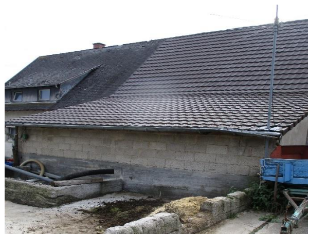
Blick von Westen auf das landwirtschaftliche Gebäude mit Spalten und Vorsprüngen und teilweise abgerissenen Misthaufen.
