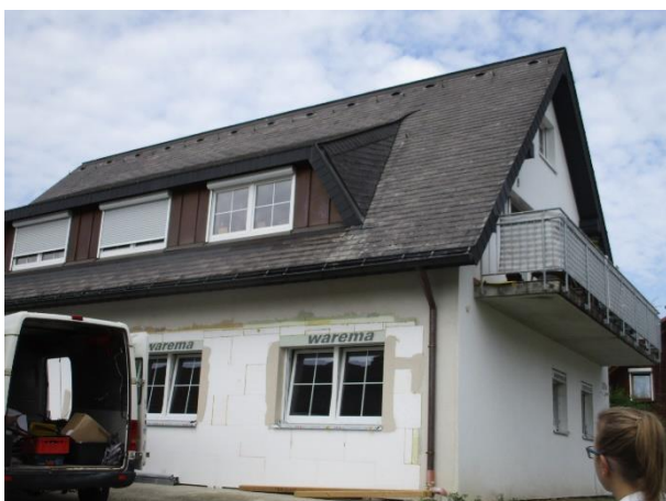
Bestehendes Wohngebäude auf dem Flurstück 866/1, welches aktuell saniert wird.
