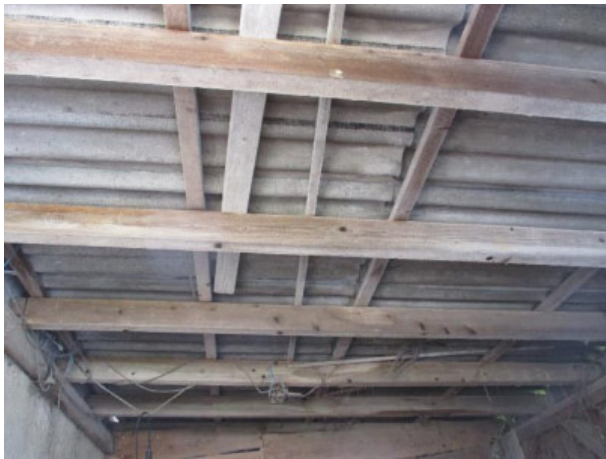
Decke des Innenraums des ehemaligen Schweinestall (Hühnerstalls).
