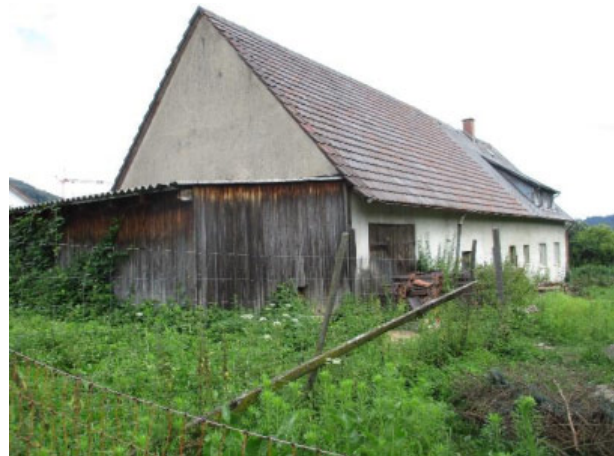
Lagerschuppen und Hühnerstall am südlichen Ende des landwirtschaftlichen Gebäudes.
